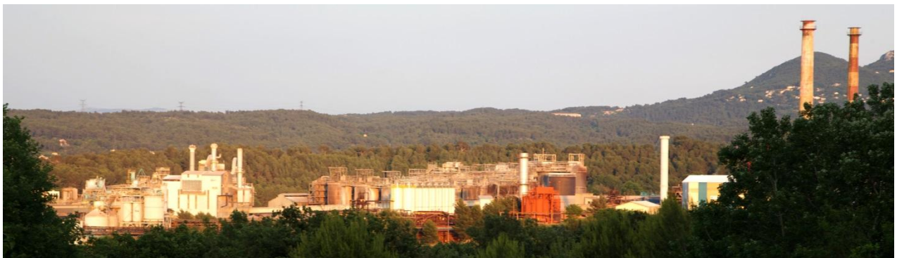
Usine de Gardanne
