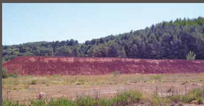
Réalisation d'une digue en Bauxaline® sur le site de Mange-Garri (mai 2006)
